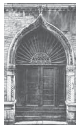
4. Venezia Porta presso il Ponte dei Calegheri
