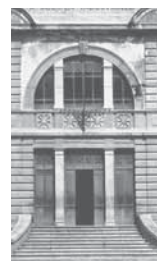
23. Potenza Particolare della Scuola Industriale
